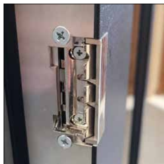
Elektrozaczep 12v Z montażem w os. aluminiowej
