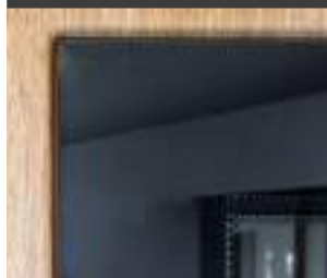
DETAL OD ZEWNĄTRZ
