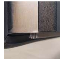
uszczelka wargowa, przyłga z uszczelką
