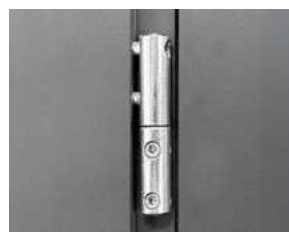
Zawiasy czopowe Ø20, regulowane 3D, wkręcane, w kolorze cynk biały, montowane w drzwiach PPOŻ. SILENZIO HAL 32, SILENZIO HAL 32 i SILENZIO 46/43/42 w standardzie
